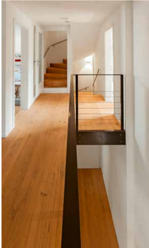
Das ehemalige zweite Treppenhäuser wurde in eine Galerie umgewandelt.
