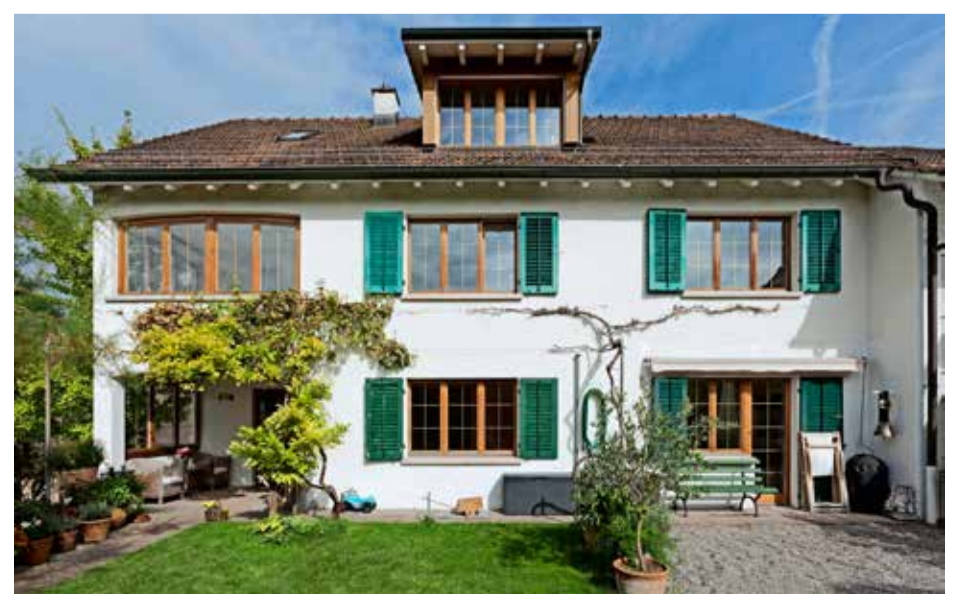
Blick vom Garten her auf das sanierte Einfamilienhaus in Birmensdorf.
